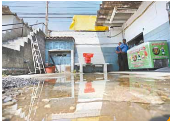
Desperdício - Vazamento de água durou quase um mês
