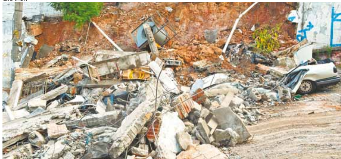
Perigo - Defesa Civil orientou que empresa faça a demolição de todo o muro. Trabalho de remoção começou ontem
