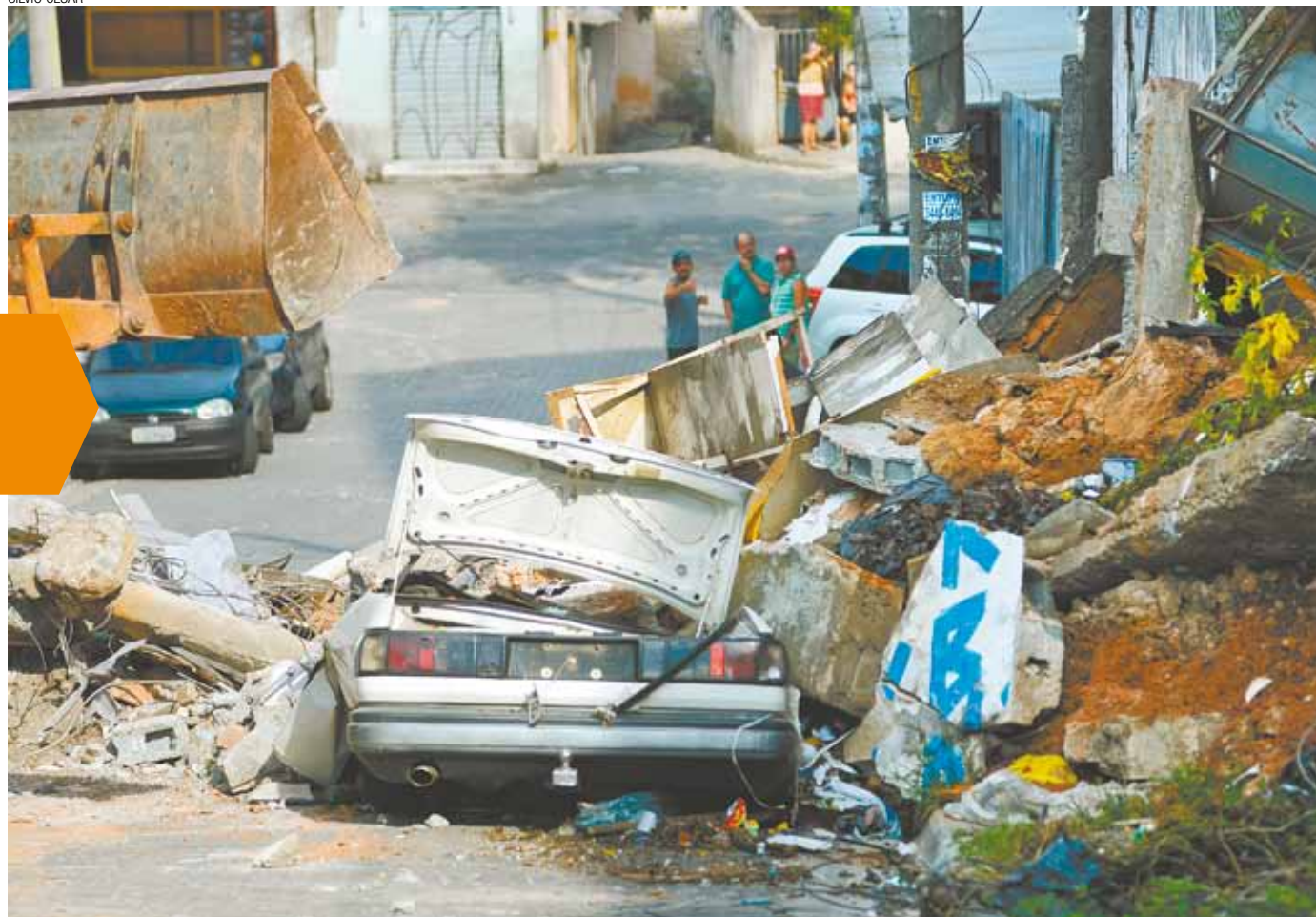
Reconstrução - Defesa Civil orientou responsáveis pela empresa a demolir todo o muro e refazer a proteção; vizinhos não foram afetados
