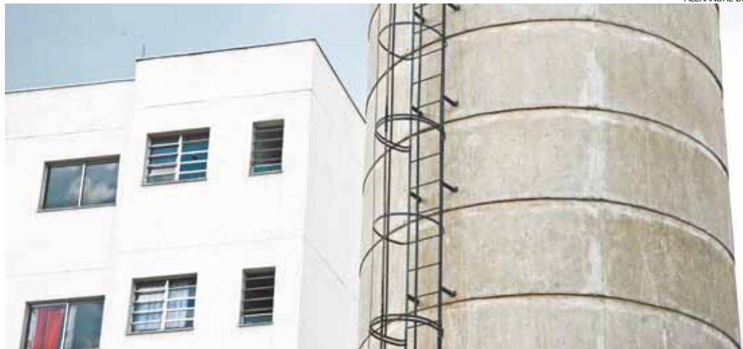
Insuficiente - Apesar de ter caixa d'água com grande capacidade, baixa pressão não abastece últimos andares
