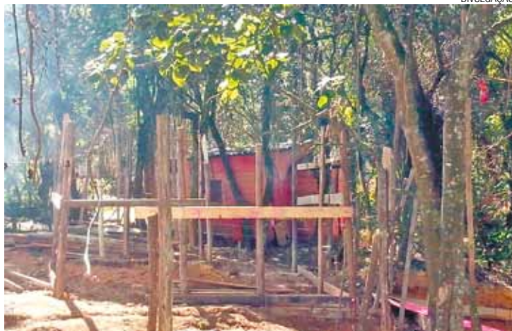
Projeto - Demarcações foram feitas com pedaços de madeira e faixas
