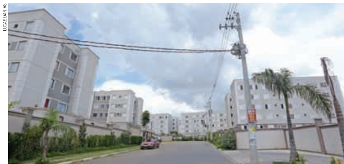
Enfeite - Condomínio Santa Mônica tem postes de iluminação prontos, mas sem energia elétrica
