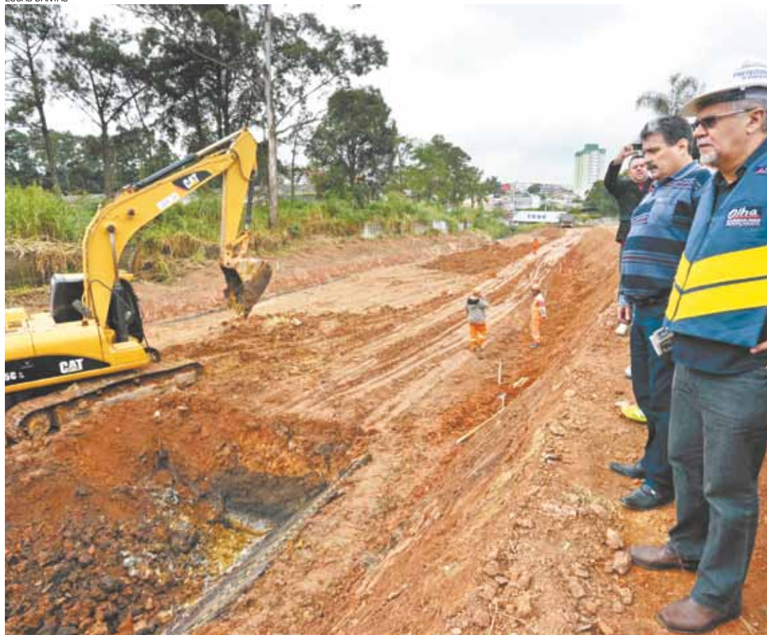
In loco- Prefeito Sebastião Almeida (à dir.) observa retroescavadeira no canteiro de obras em Bonsucesso
