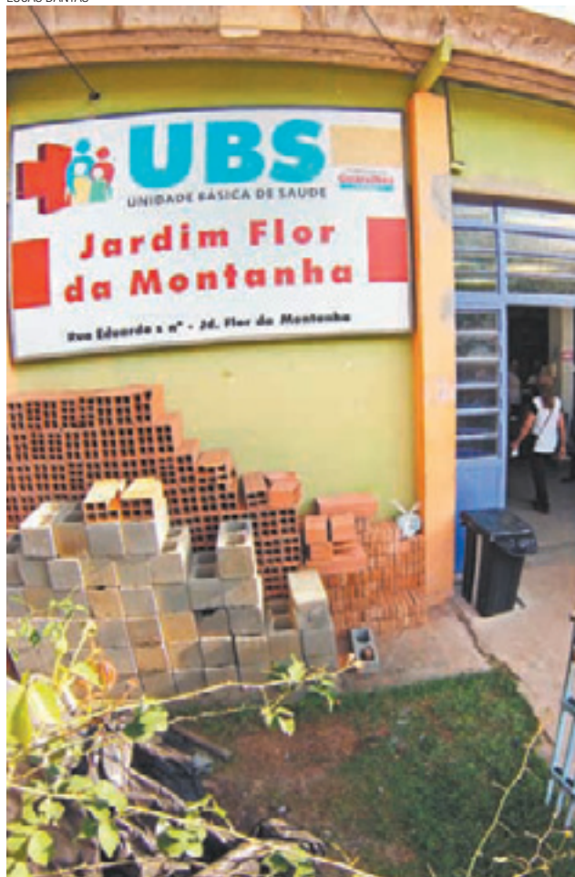
Obras - UBS Flor da Montanha continua em ritmo de reforma
