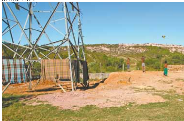
Perigo - Crianças empinam pipa ao lado de torre da rede elétrica
