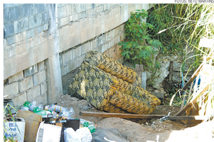
Fechado - Blocos de concreto fecharam o escoamento dos resíduos
