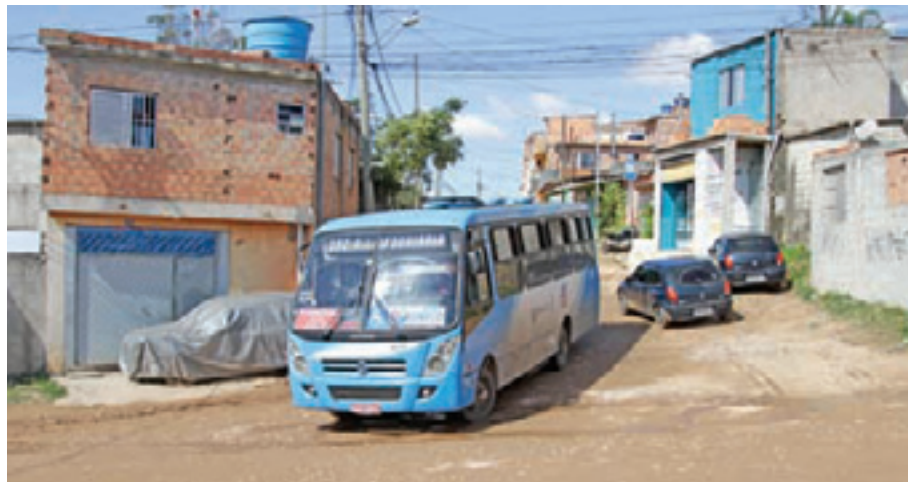
Na lama - Local importante na região, a Rua Santo Estevão fica prejudicada por causa do barro
