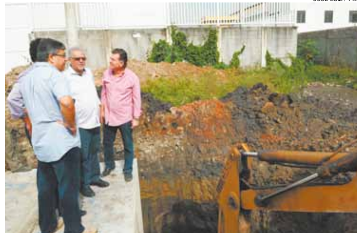
Vistoria - Almeida visitou obras em Cumbica, junto com secretários
