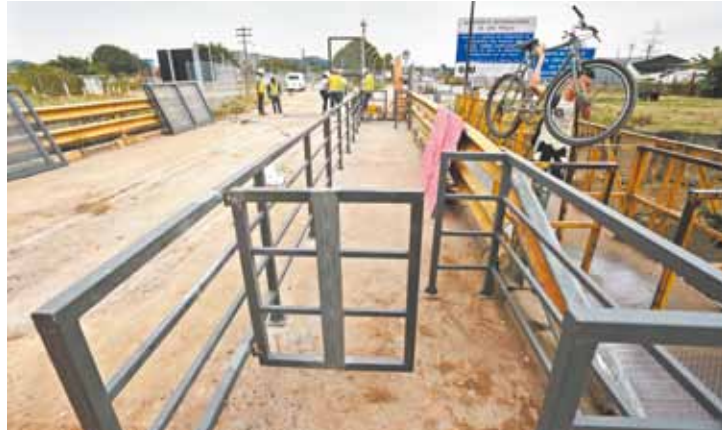
Semiaberta - Um portão de acesso foi instalado no local
