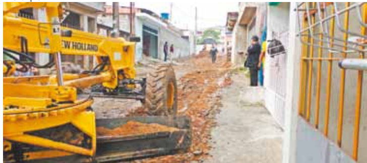
Máquinas - O calçamento da via teve início após várias reclamações
