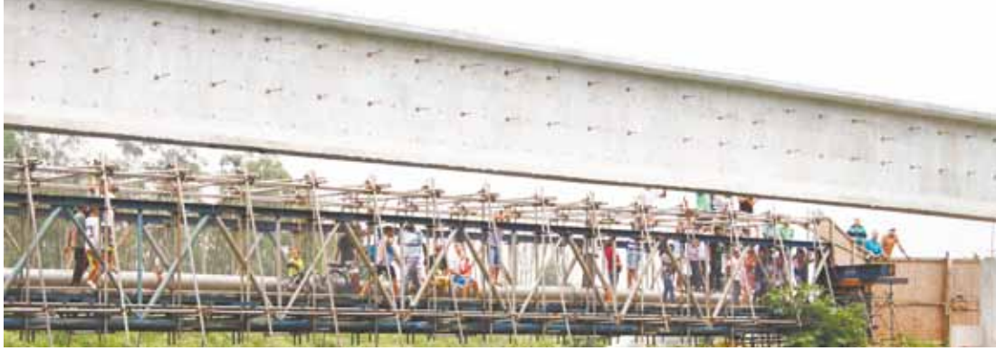
Paralelas - Estrutura metálica montada no local da antiga ponte contrasta com viga de concreto instalada ontem
