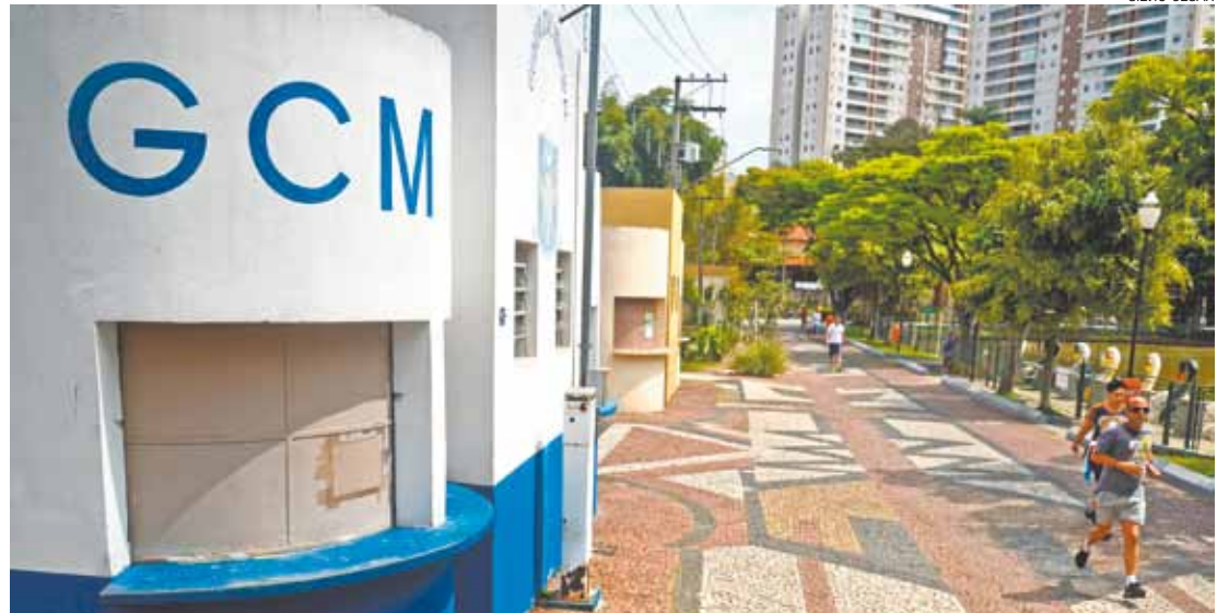
Abandono - Base da Guarda Civil Municipal no Lago dos Patos, fechada, fotografada na semana passada
