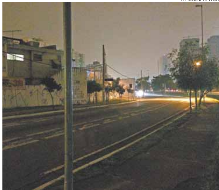
Escuridão - Techo de 450m da Avenida Transguarulhense está sem luz
