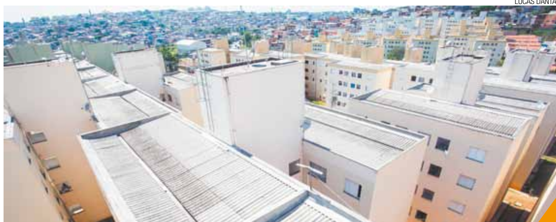
Vazamento - Moradora tem que conviver com goteira no teto e mofo nas paredes do apartamento
