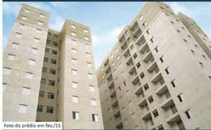
Foto do prédio em fev./15
