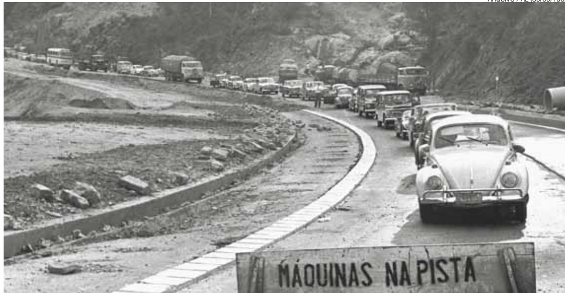
Obras - Carros trafegam em trecho durante duplicação da Via Dutra, principal ligação entre São Paulo e Rio
