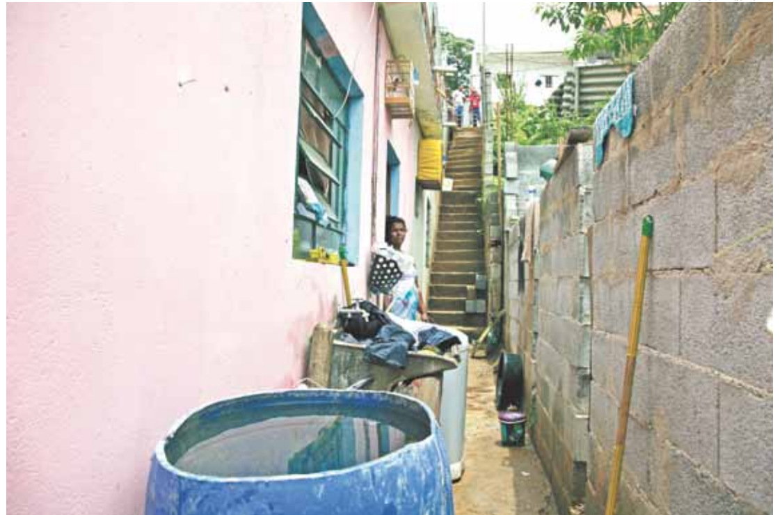
Risco - Armazenamento inadequado de água em tonéis, sem tampa, torna-se foco de proliferação do mosquito
