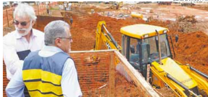
Vistoria - Prefeito Sebastião Almeida visita obras do Sesc, na Vila Barros
