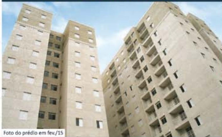
Foto do prédio em fev./15
