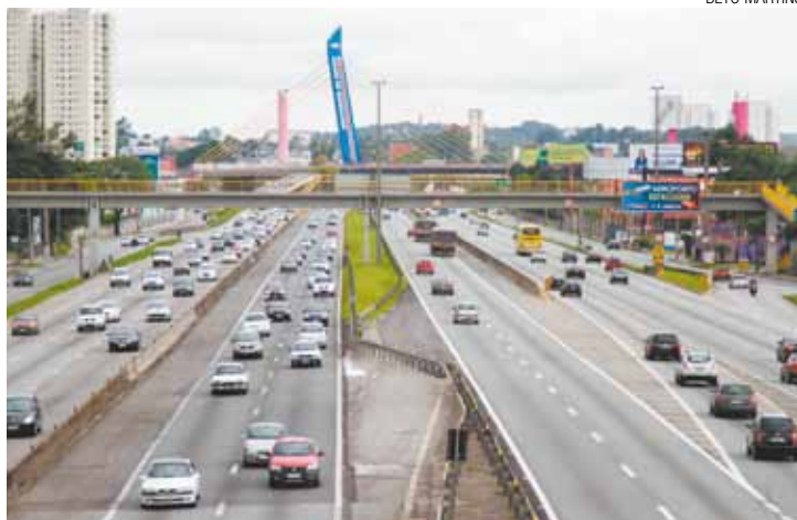
Dutra - Não houve congestionamento na principal via que corta a cidade
