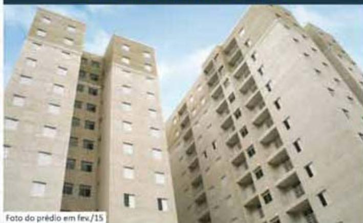
Foto do prédio em fev./15
