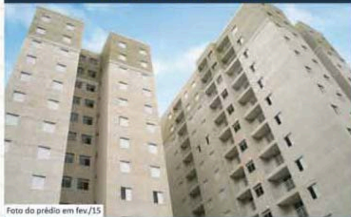
Foto do prédio em fev./15
