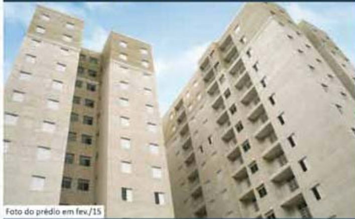
Foto do prédio em fev./15
