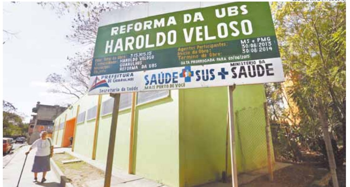
Atraso - Obras começaram em 2013 e deveriam terminar em 2015, mas apenas três das 34 UBSs estão prontas
