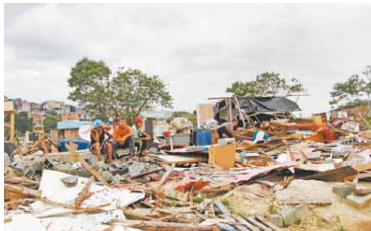
Destruição - Moradores se apoiam no que restou após a demolição
