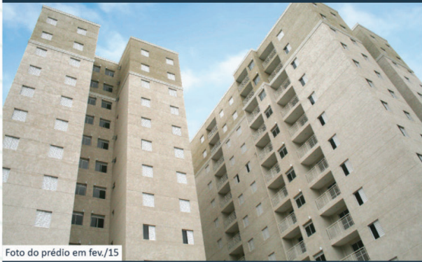
Foto do prédio em fev./15
