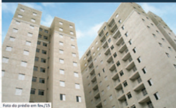
Foto do prédio em fev./15
