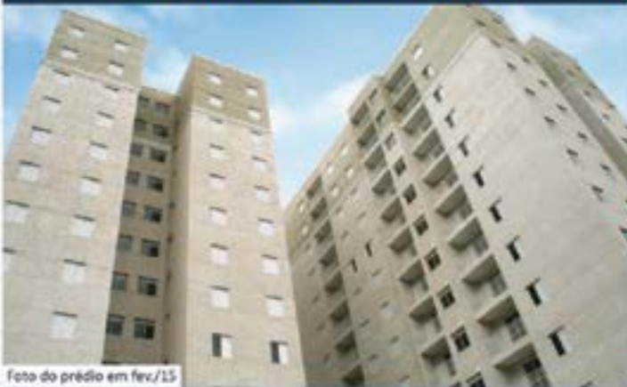
Foto do prédio em fev./15
