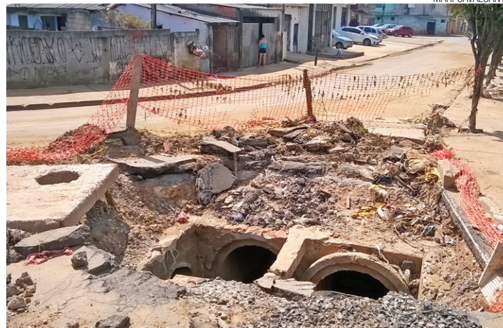
Caixas - Subdimensionamento teria impedido continuidade da obra
