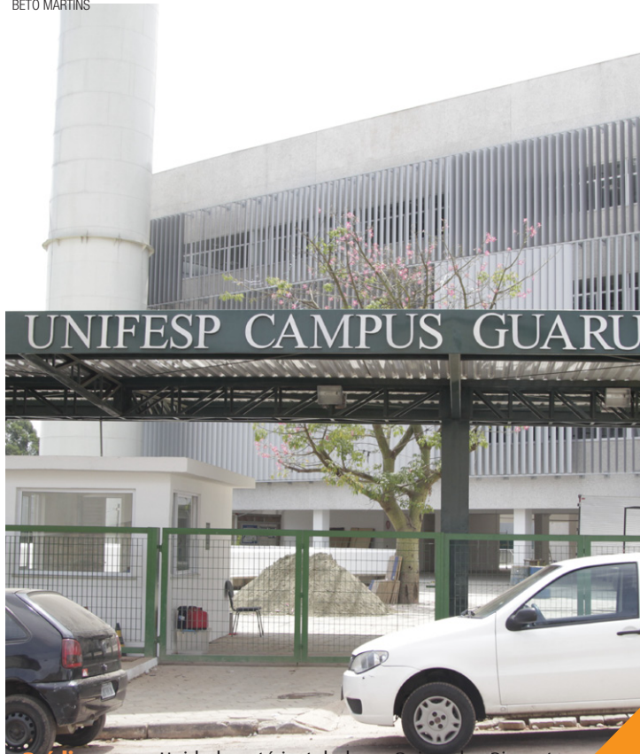
Prédio novo - Unidade está instalada no Bairro dos Pimentas
