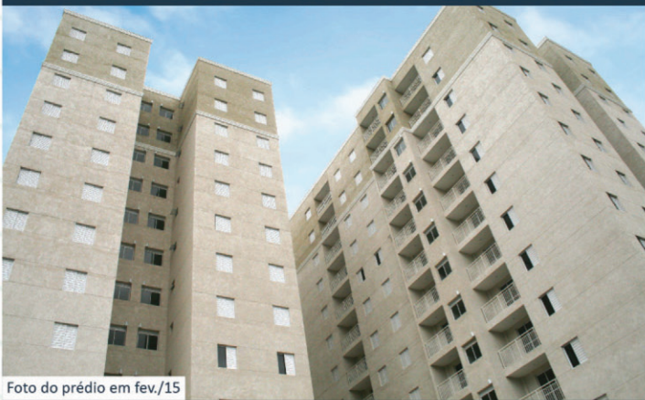
Foto do prédio em fev./15
