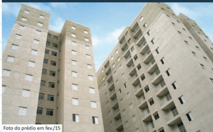
Foto do prédio em fev./15
