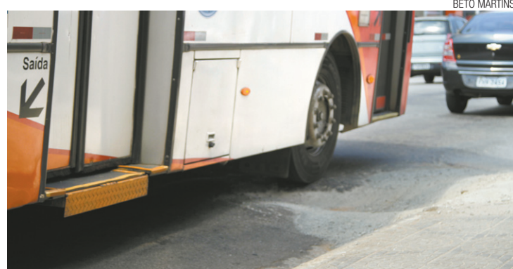
Perigo - Veículos dificilmente conseguem desviar do buraco, no Centro
