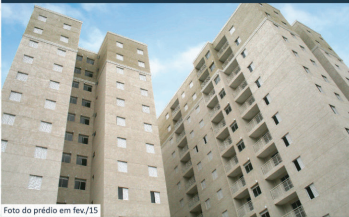
Foto do prédio em fev./15
