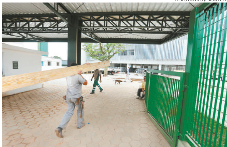
Moroso - Entrega das obras no bloco em reforma foi adiada seis vezes
