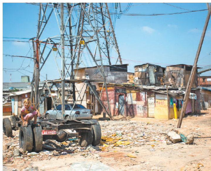
Perigo - Famílias vivem em terreno onde há fios de alta tensão
