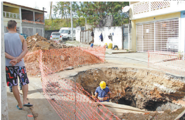
Cratera - Rompimento de galeria de esgoto causou erosão do solo na via
