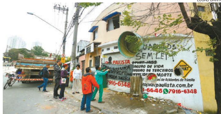
Protesto - Acesso à via chegou a ser fechado, mas não evitou a demolição
