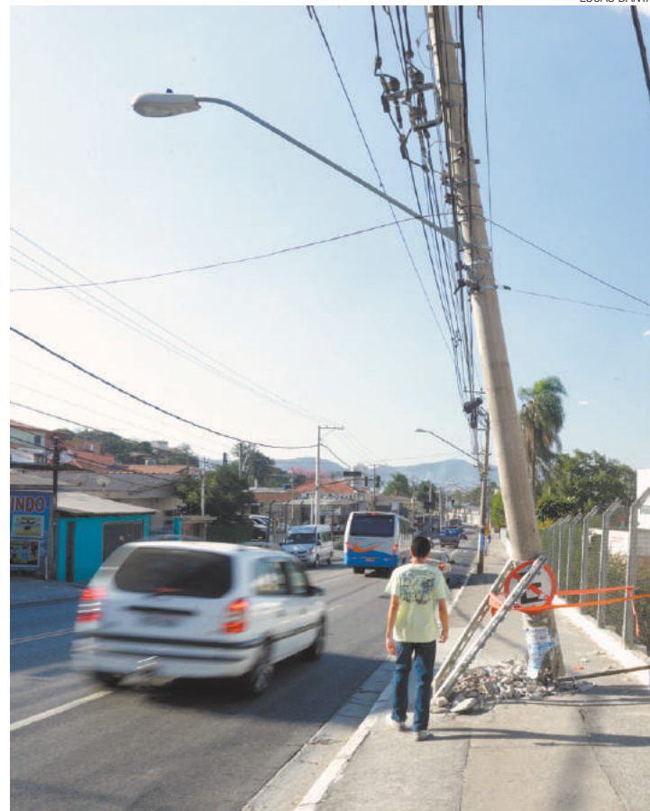
Gambiarra - Coluna está escorada por duas vigas metálicas e uma fita
