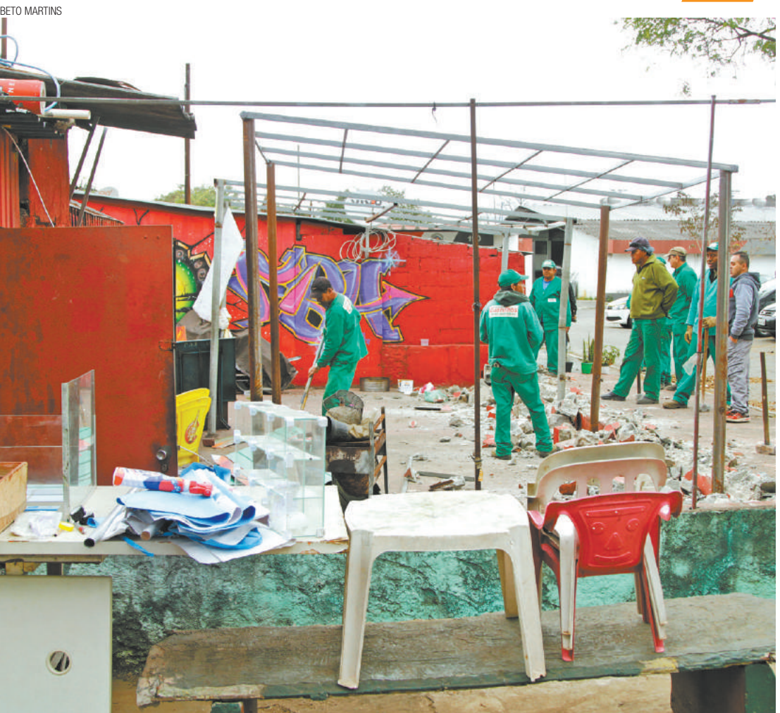
Fim - Grupo de funcionários da Prefeitura demoliram estruturas de alvenaria anexas aos trailers, ontem
