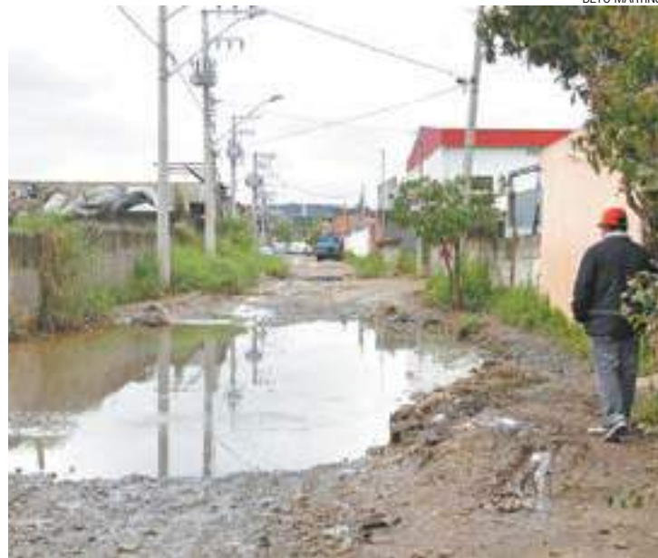
Dificuldade - Vazamento constante prejudica passagem de moradores
