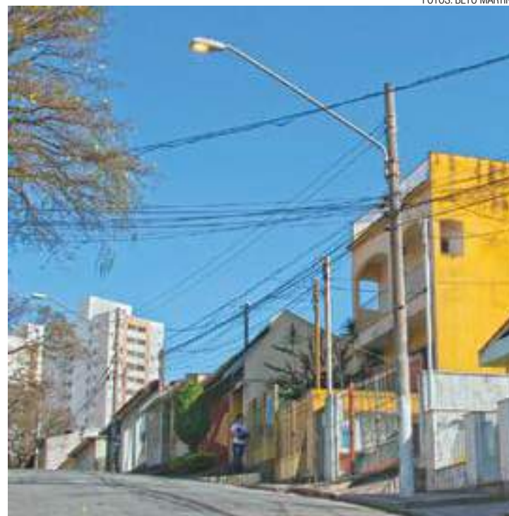
Rua Tupirantins - Vila Rosália tem via com iluminação durante o dia
