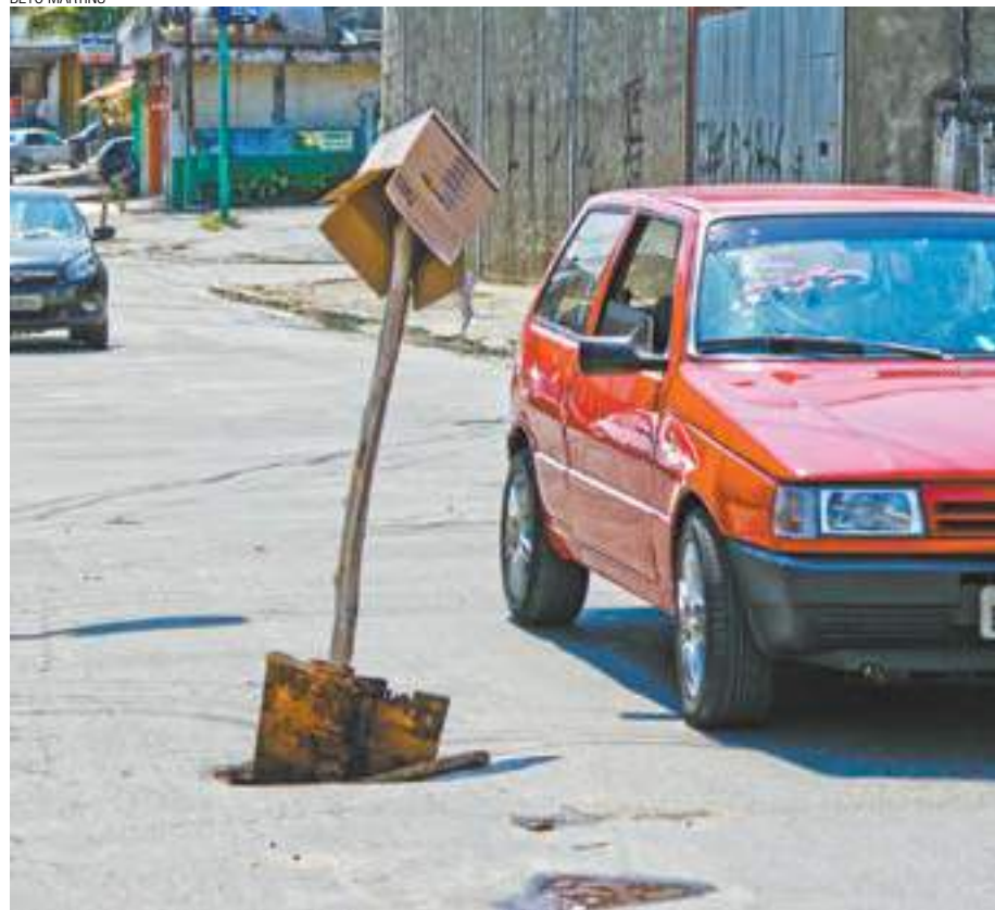
Sinalizado - Bueiro tem a tampa estourada na Rua São Bento do Trairi, no Jardim São João
