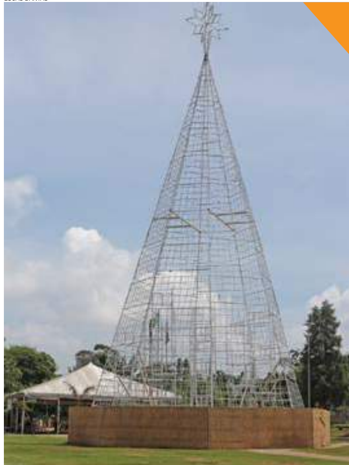
Atraso - Estrutura do ano passado levou meses para ser desmontada
