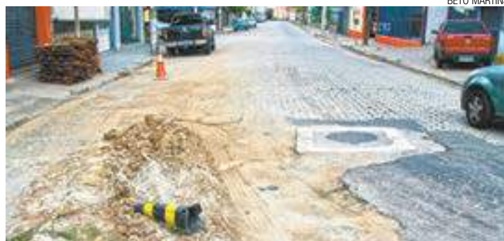
Reparo - Saae informa que a recuperação do pavimento está programada
