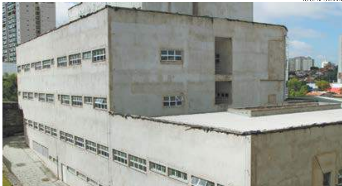
Acabamento - Para finalizar obra é necessário mais um ano de trabalho para pintar, energizar e acertar detalhes
