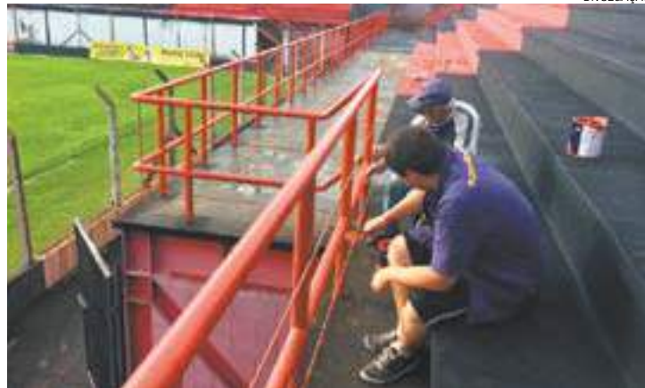
Voluntários - Torcedores realizam pintura e finalização dos preparos
