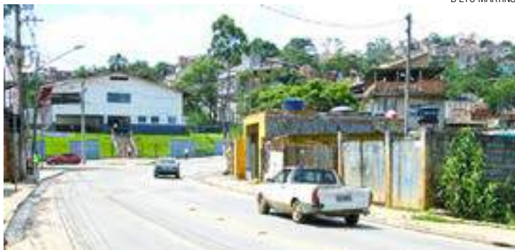
Próximo de creche - Esgoto também escorre pela Rua Felipe Marcondes
