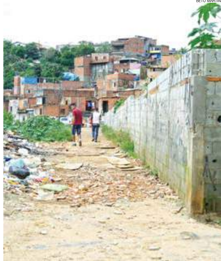
Vistoria - Constatadas irregularidades, responsável será notificado pela SDU
