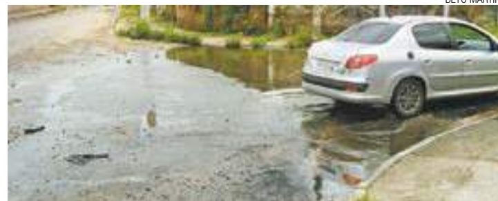
Rotina - Segundo moradores bueiros entopem e provocam alagamento
