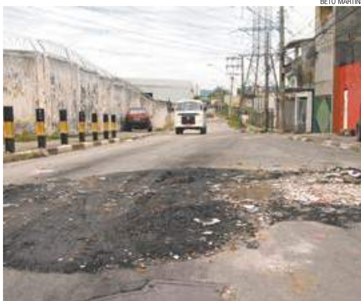
Reparo - Pavimentação foi reforçada com terra e entulho por moradores
