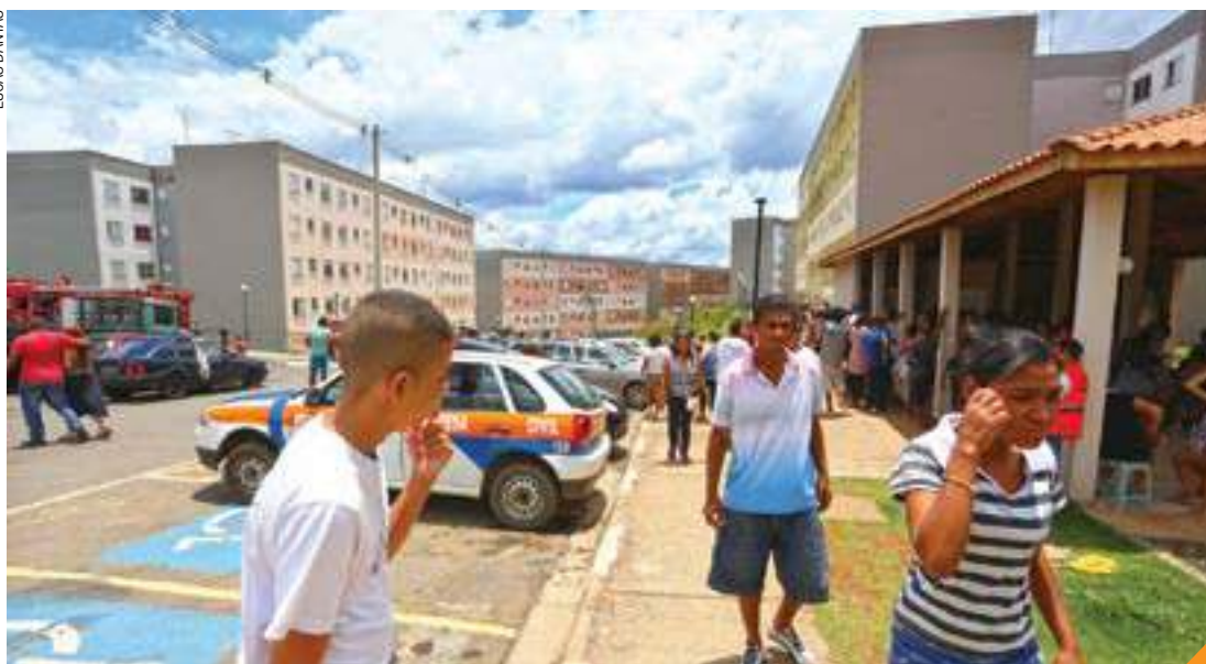
Precaução - Corpo de Bombeiros e Defesa Civil estiveram, ontem no local, avaliando as condições
