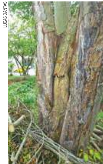
Perigo - Galhos estão quase se soltando dos troncos e vão cair
